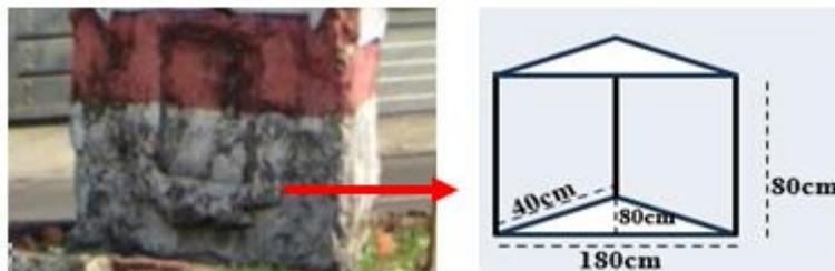
**Gambar 8.** Struktur Gardu Soblok Berbentuk Prisma segitiga
